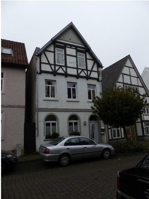
Fachwerkgiebel zwischen Fachwerk l. u. r.
