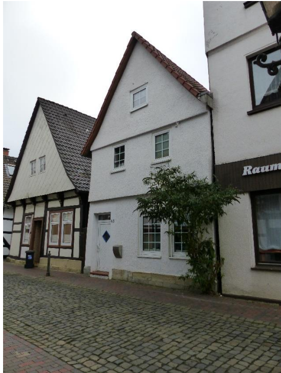
Fachwerkgebäude (verputzt, Fachwerkgruppe I.)
