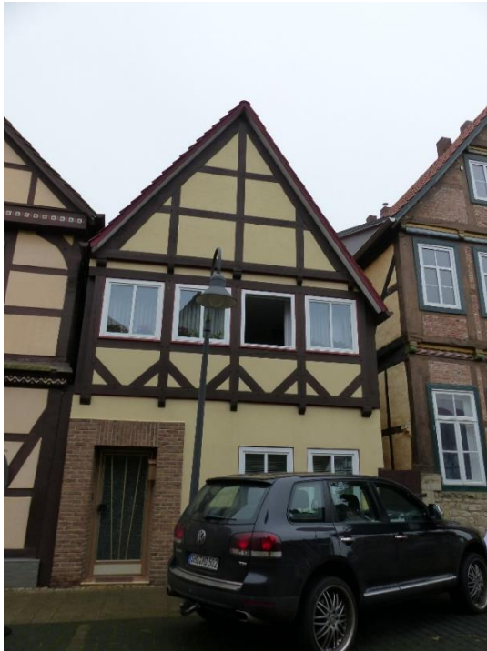
Fachwerkfassade (Fachwerk l. u. r.)
