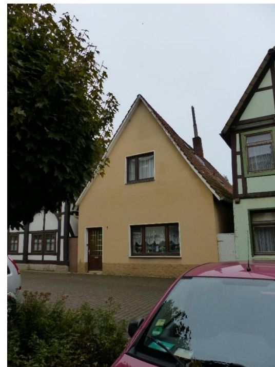
Nachkriegsbau (Fachwerk l. u. r.)
