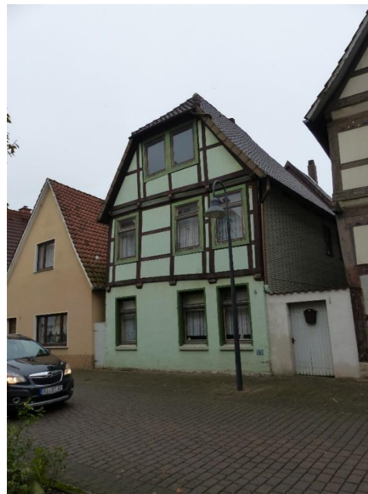
Fachwerkgebäude (Fachwerk rechts)
