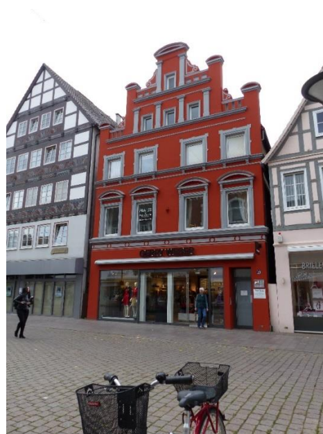
Klassizistische Fassade (Fachwerk l. u. r.)
