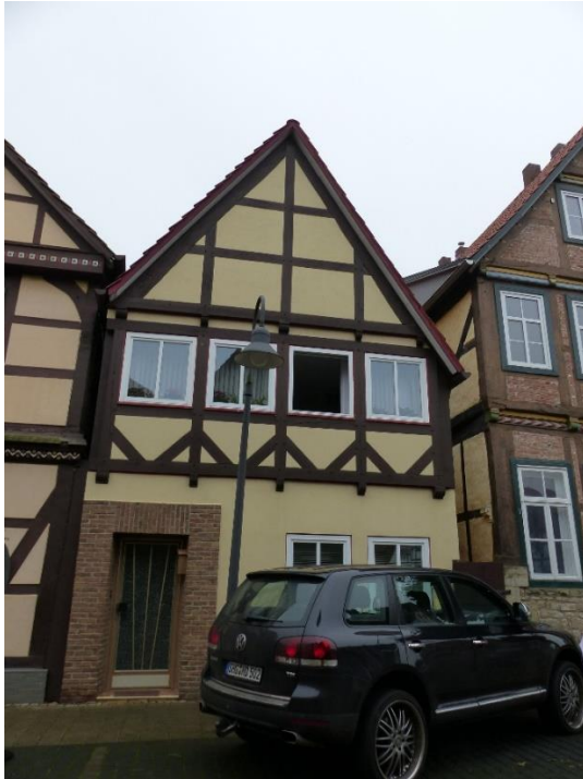
Fachwerkfassade (Fachwerk l. u. r.)
