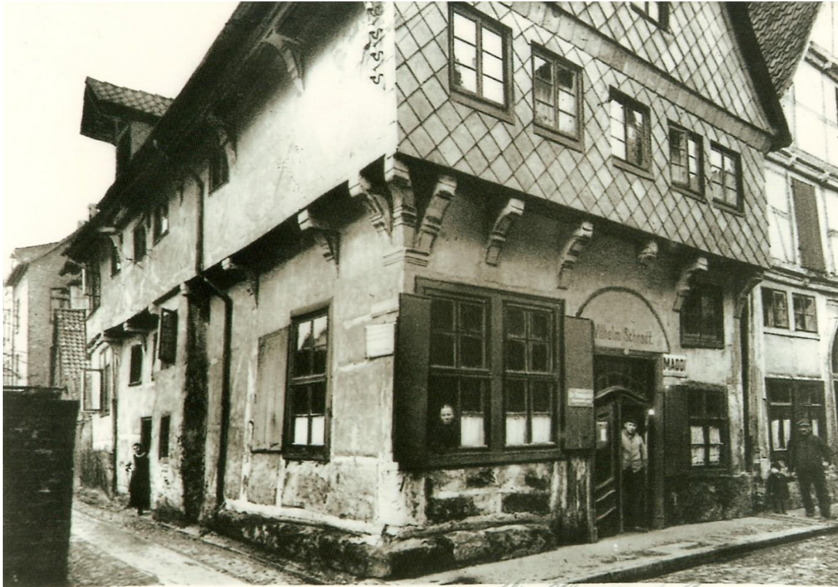
Foto des 1972 abgebrochenen Hauses, heute Parkfläche
