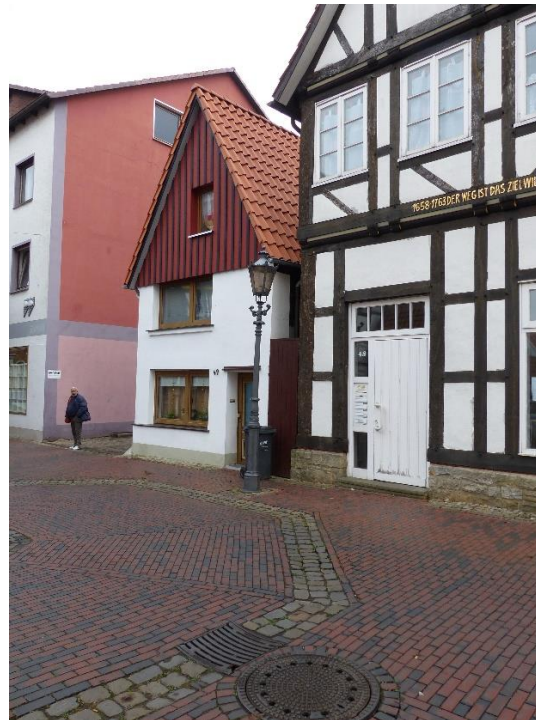
Fachwerkgebäude (verkleidet, Fachwerkgruppe r.)
