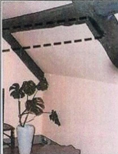
Die Zugbalken halten die beiden Seiten des Daches eigentlich zusammen.
