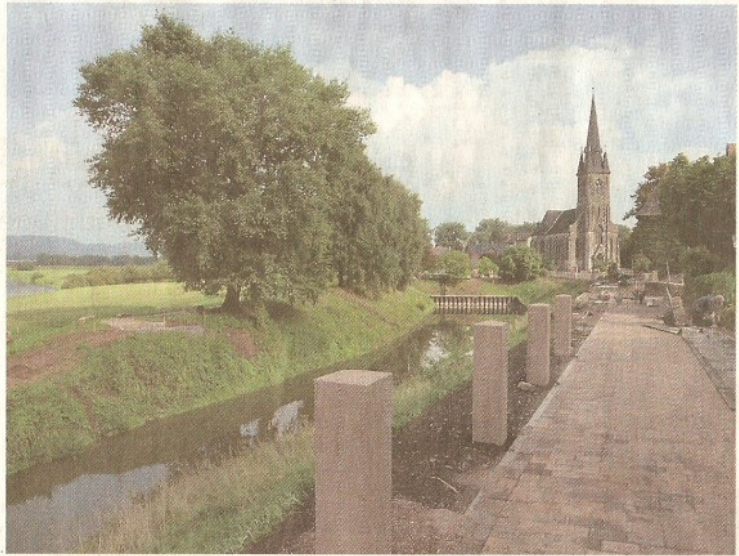
Bauarbeiten auf dem Wall am Alten Hafen. Die projektierte Brücke steht nach wie vor in der Diskussion. toj
